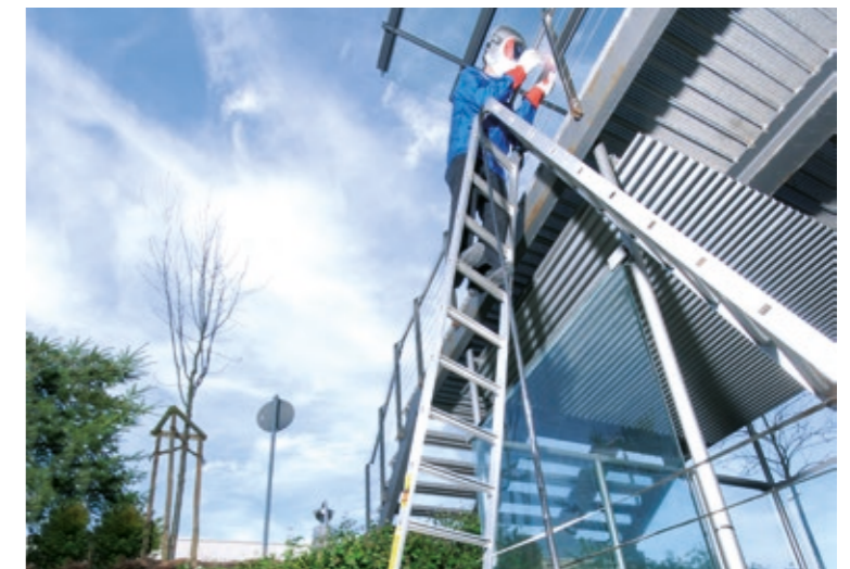
Praxisbeispiel: die Endmontage eines Geländers – ein typischer WIG-Schweißjob. Aber im Treppenhaus gibt es noch keinen Stromanschluss. Also muss entweder ein Generator her – oder Sie schließen Ihr Lorch Schweißgerät einfach am Akku an. Problem gelöst!
